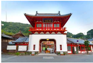
(武雄温泉楼門)
